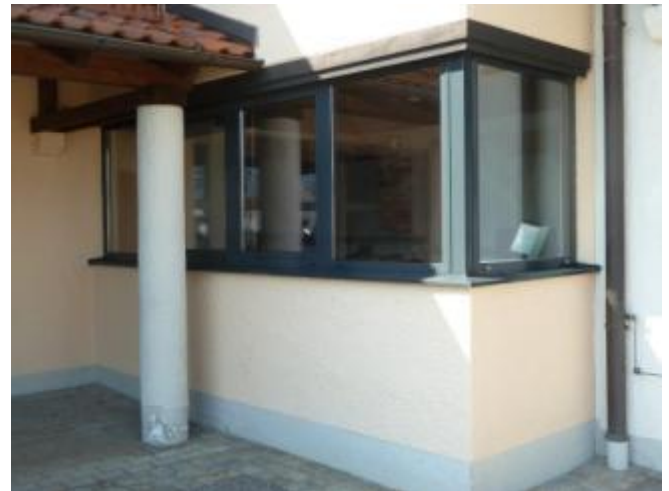
Neue Fenster für die Einsatzzentrale
